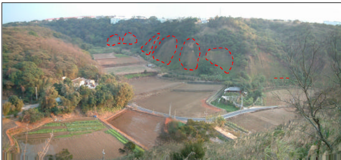
照片 3-2 河岸旁間隔的大型崩塌地 地點: 員林坑溪, 2004/01 攝
