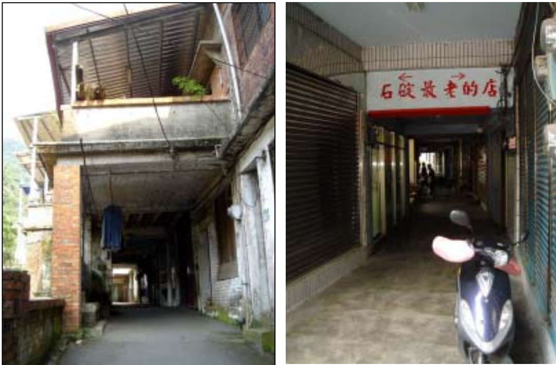
圖 3-11 石碇東街不見天街外觀及內部。資料來源：本研究拍攝，民 93。
