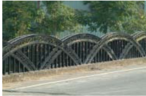
(圖 1)復育中的桃米溪橋鑄鐵欄杆
