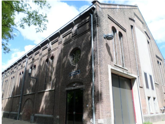
圖 4-19 轉型建築(Transformatorhuis)
