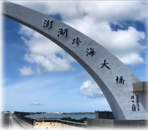
澎湖跨海大橋
