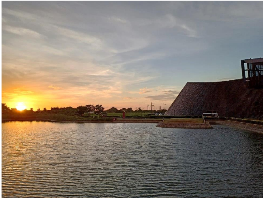
圖 4-1 位於故宮南院左側的國寶館預定地 (資料來源：林詩晏，2020。)
