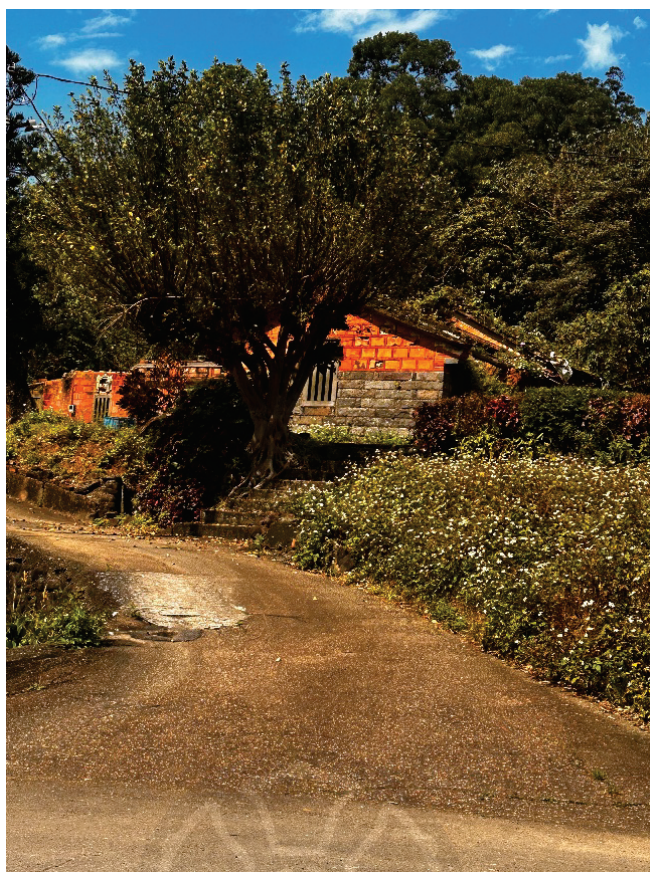
圖 2-28 位於屯山里的石頭厝：以安山岩建築房屋
