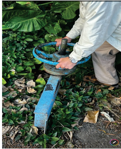
圖 2-23 埤堵為控制水圳水流量的閘門，控制閘下是水圳水流通道
