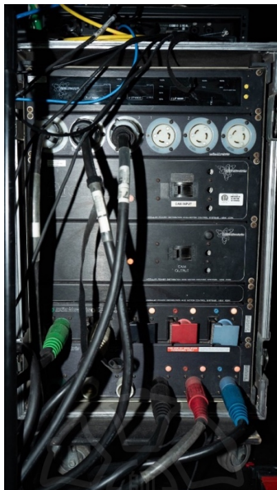
圖 23 AC Power 系統背面 (2023 研究者自攝)
