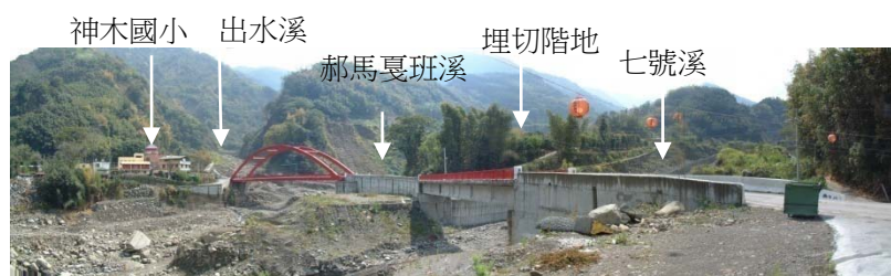
照片 5-9 和社溪河道堆積(2003.03.07 沈淑敏攝)
