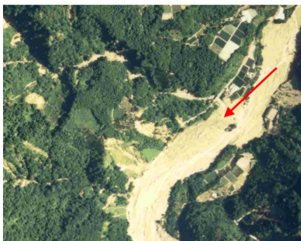
照片 5-5 四號溪桃芝颱風後航照上的土石流扇
