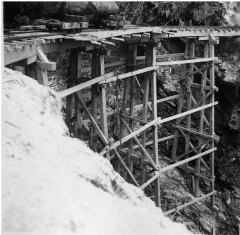
圖 3-3 太魯閣地區運材軌道
