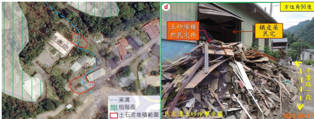
圖 3-37 PG08 土石流災後正射影像(右)與土石流堆積近照(左)(照片轉載自水土保持局，2015)
