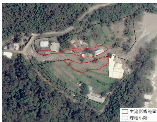
圖 3-20 小坑溪下游蘇迪勒颱風後之正射影像(位置參見圖 3-17b)
