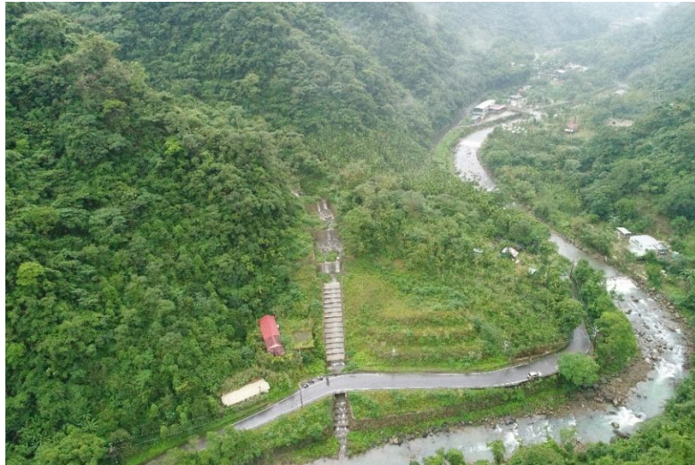
圖 3-36 PG44 土石流扇整治後之空拍影像(2017.11.26 拍攝)
