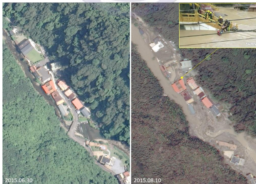
圖 3-16 蘇迪勒颱風前後平廣溪下游(2)河段局部放大之正射影像 (位置參見圖 3-13 白框 c)
