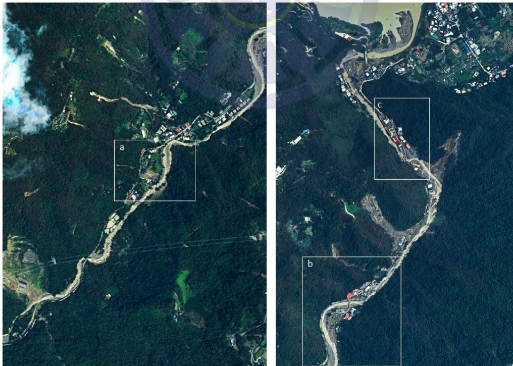
圖 3-13 蘇迪勒颱風後之平廣溪下游河段整體航照影像 左為下游(1)、右為下游(2) (航照影像拍攝時間：104.08.10)
