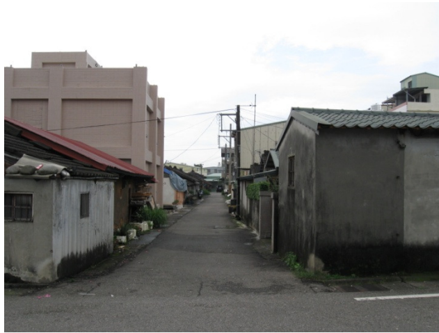
照片4-11 馬力埔地區老建物進行部分整修，將瓦製屋頂改為鐵皮仿瓦屋頂。
