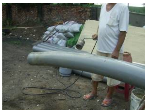
圖 5.7 用瓦斯槍烘烤膠管
