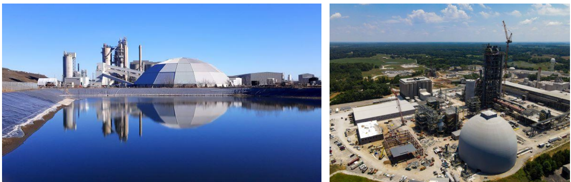
圖 2- 32 興登堡 EcoCem®PLC 低碳廠區全貌
