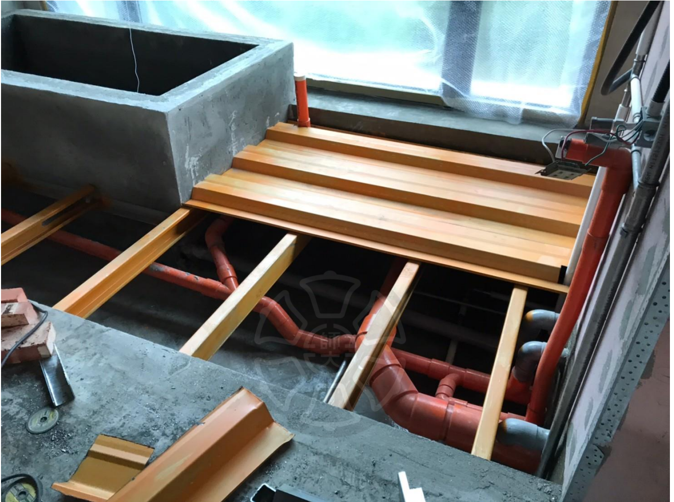
圖 4-25 案例 B 於室內接觸溫泉區域結構與底材皆以抗磺或防磺基材為應用
