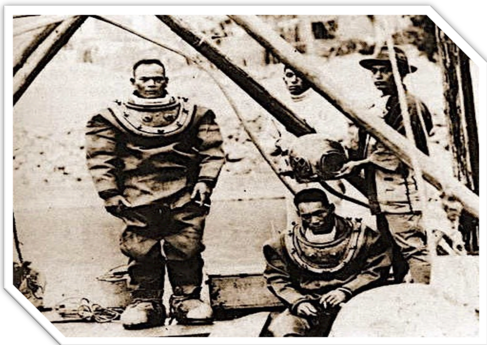
圖 4-2-4 鐵道橋墩工事潛水人夫之裝備
