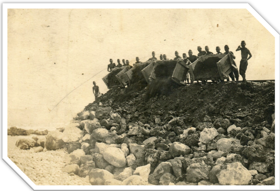
圖 4-2-6 阿美人修築新港漁港防波堤的情況
