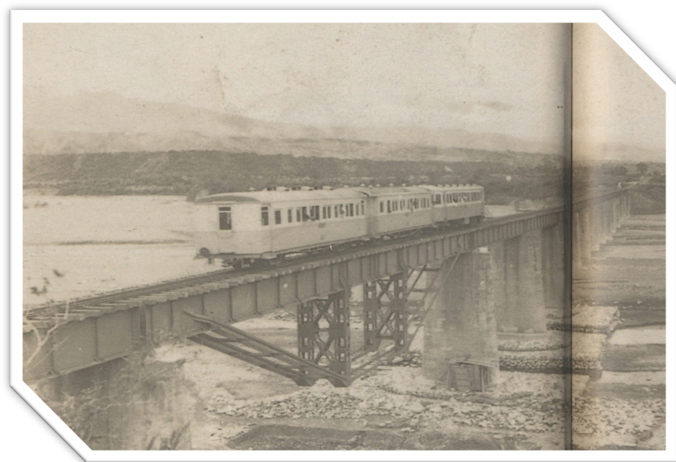
圖 4-2-3 跨越花蓮木瓜溪的鐵道鐵橋
