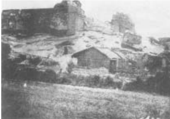
圖 3-3 日據之初熱蘭遮城的斷垣殘壁，上端城壁之缺口，乃光緒元年（1875 年）沈葆楨建億載金城時挖去大量磚石所致。
