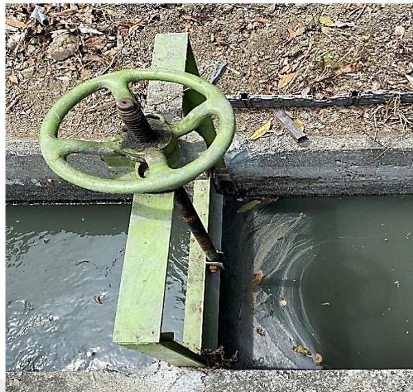
圖 4-4 大寮堤防附近灌溉溝廢水污染
