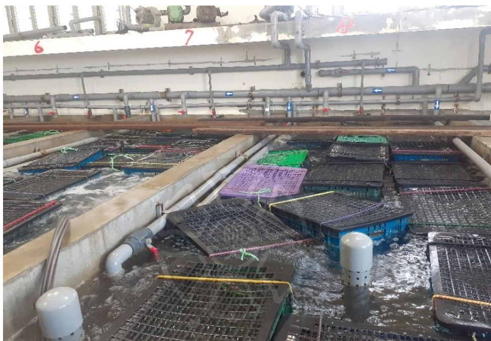
圖 4-6 活蟹蓄養池與相關設備
