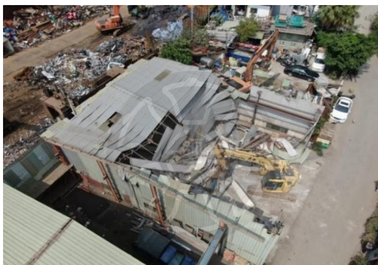
圖 4-1-14 違章廠房拆除作業
