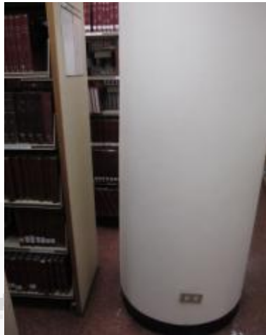
PG-10 書櫃、插座與柱子的位置排列，可能會干擾到讀者行進間的通暢程度。
