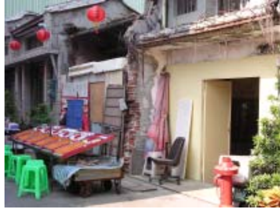
圖 4-4 因拓寬道路而部分拆除的建築，少數至今仍未整修或改建。
