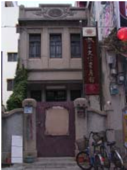
圖 4-9 閒置民居再利用－「安平文化資產館」
