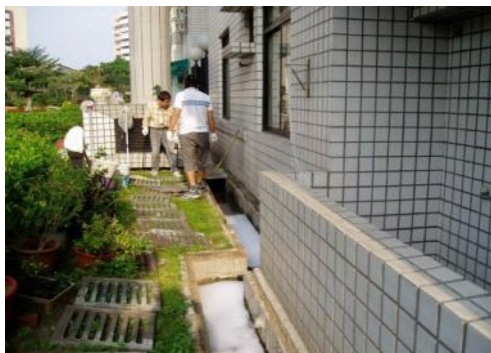
圖 4-3-1 社區水溝污泥清理
