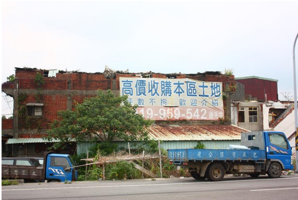
【圖 4-1】攝自筆者家鄉「鳳鳴重劃區」房屋的拆毀過程。
