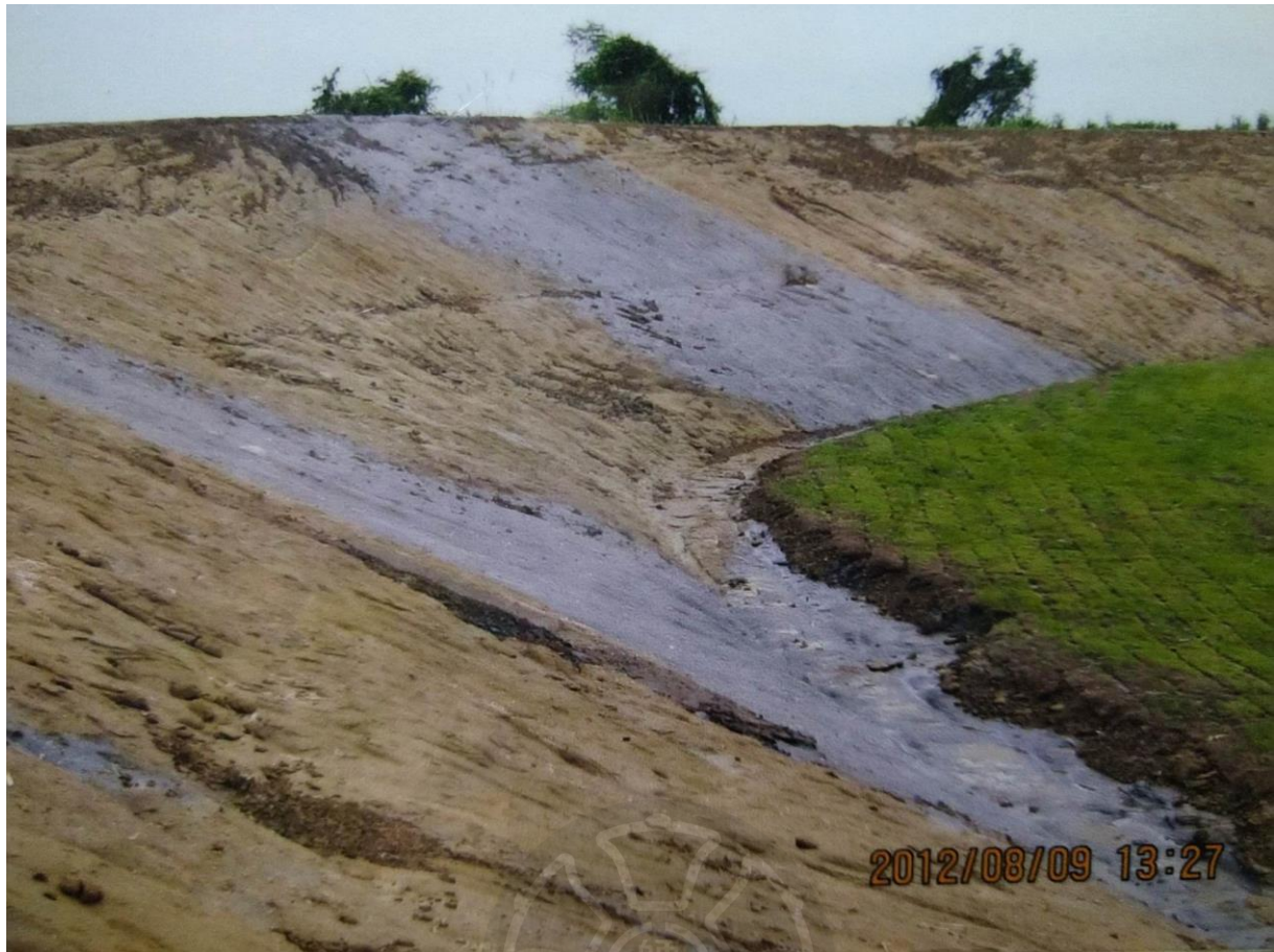
圖 2.3 照片中為採集本研究之化石的地層原始樣貌，當時正在為後續日出亭的新建工程進行整地。根據王良傑先生所述：本露頭灰色的部分為泥岩、棕黃色的部分則為砂岩（照片提供：王良傑先生）。
