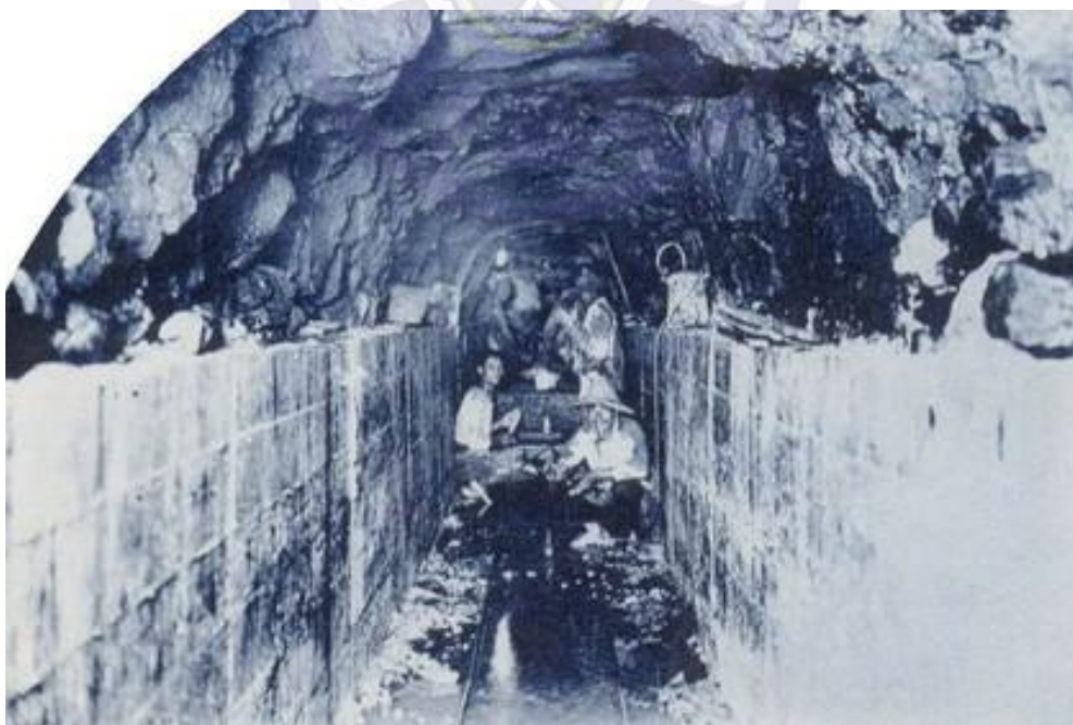
圖 3-34 「馬公水道」之貯水隧道掘鑿作業狀況
