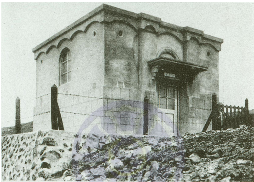
圖 3-30 「馬公水道」之人孔井建築
