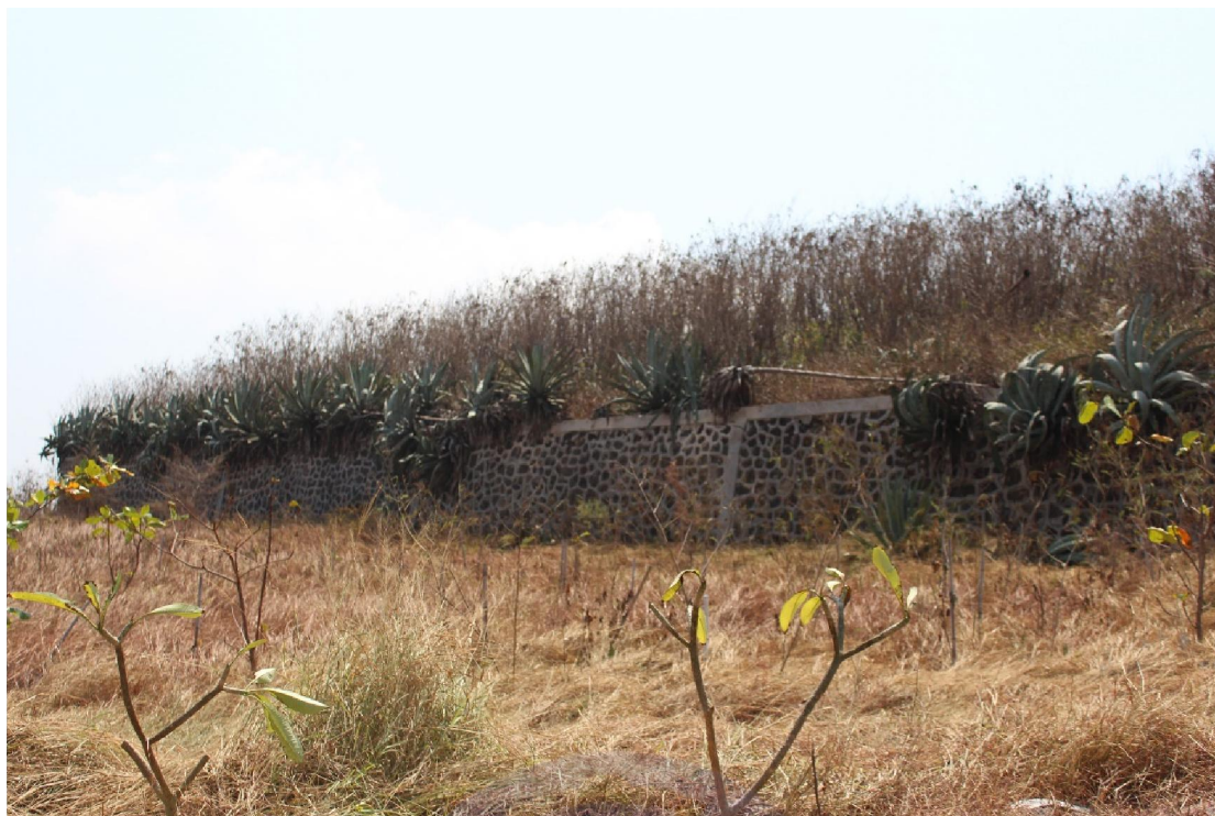
圖 3-20 馬公要港部淨水貯水設施外牆一部（筆者攝，2019 年 10 月 3 日） 說明：「馬公要港部水道」之菜園淨水貯水設施外牆，種植銀河歡、瓊麻偽裝，外牆以玄武岩砌成。
