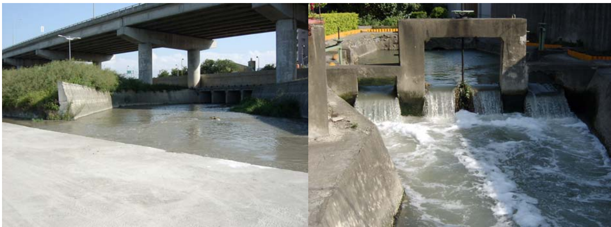
圖2-3-1 烏瓦窯圳取水口（溪州橋下附近） 圖2-3-2 烏瓦窯圳下游（苦苓腳聚落旁）
