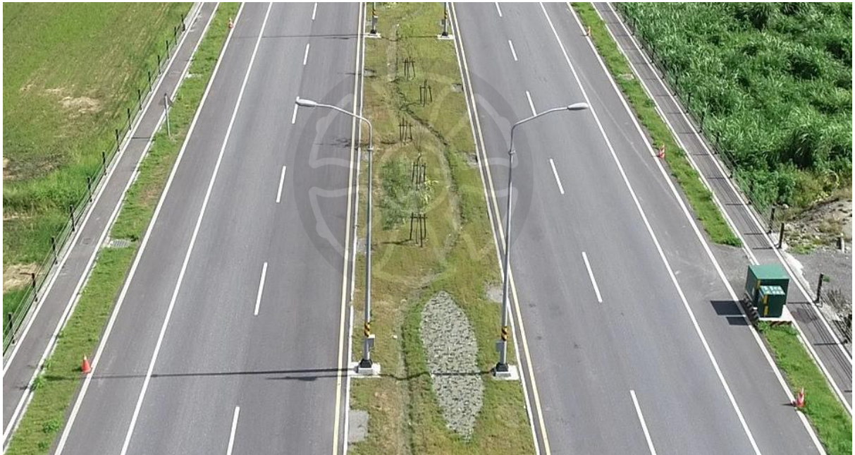
圖 4-18 富源至瑞北路段安全景觀大道計畫完工後照片
