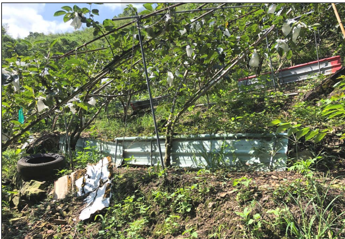
圖 2-9 以浪板製作而成的簡易擋土牆
