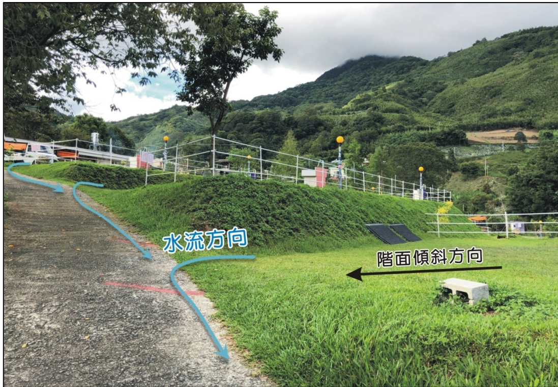
圖 3-16 階面向內傾斜的排水路線規劃
