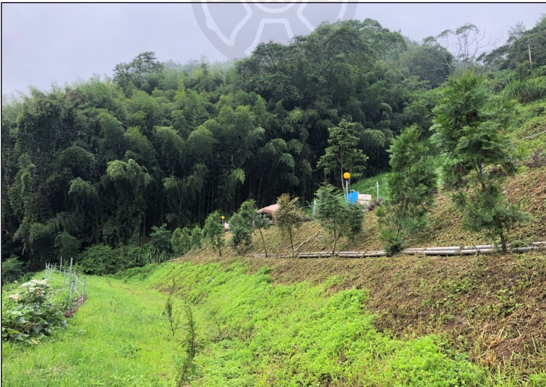
圖 3-15 分階段且種植肖楠的邊坡設計
