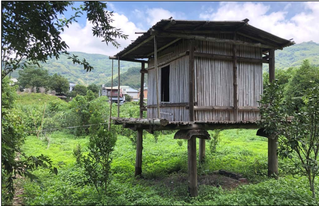
圖 1-7 以竹子搭建的高腳屋建築
