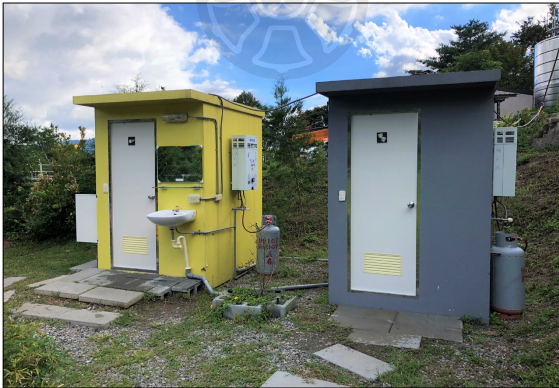
圖 3-9 露營區的廁所及衛浴設備
